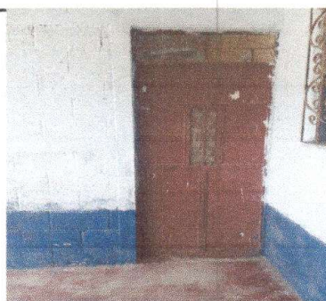
Foto 4: sustitución de puerta en dirección
