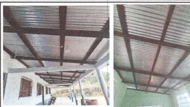
Foto 2: sustitución de soporte de madera, por metal
