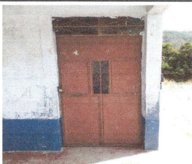
Foto 3: sustitución de puerta de aula
